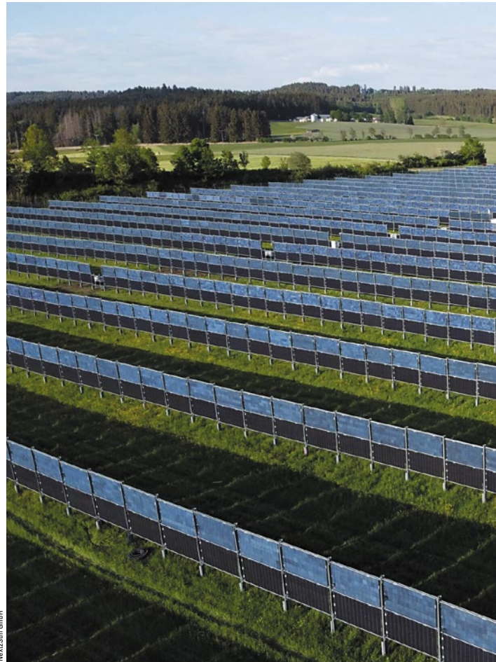
Statt oberhalb der landwirtschaftlichen Fläche können Solarmodule auch in senkrechter Schichtung, können dann zwischen den Reihen zum Beispiel Kühe weiden
