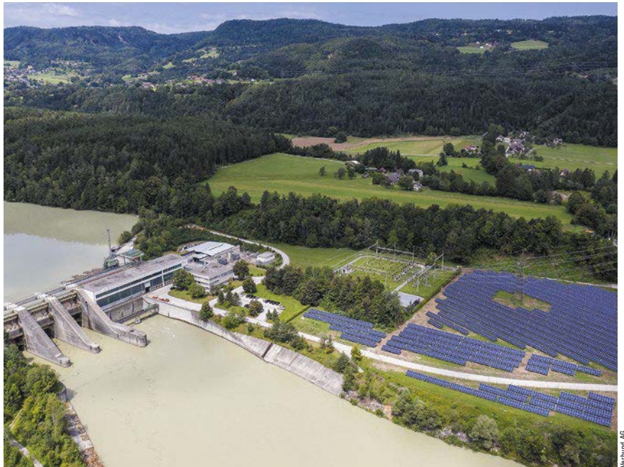
Neuausrichtung: Der österreichische Stromversorger Verbund AG nutzt bislang fast nur Wasserkraft, Photovoltaik spielt – wie hier die 1,3-Megawatt-Anlage am Wasserkraftwerk Feistritz in Kärnten – nur eine marginale Rolle
