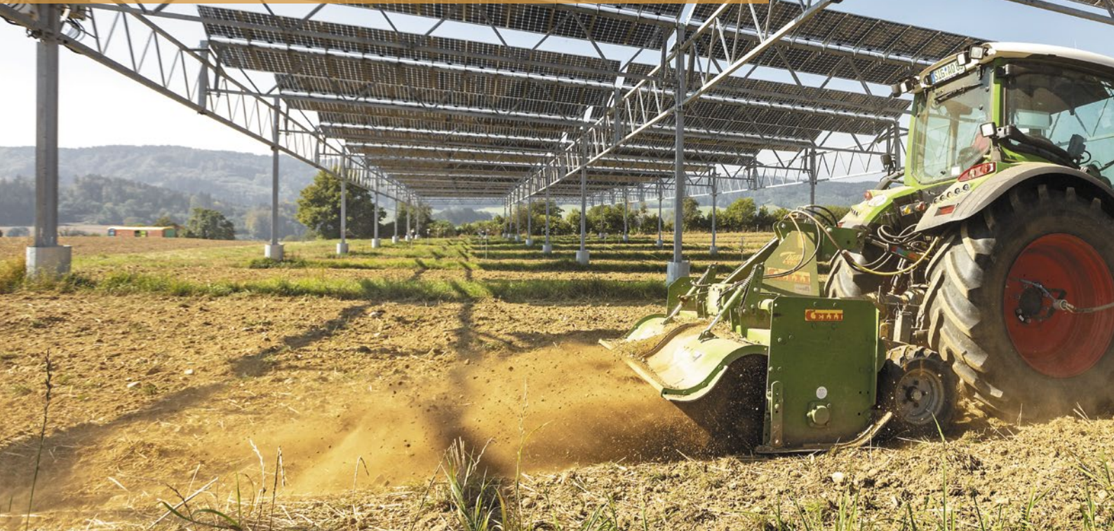
Forschungsanlage in Heggelbach am Bodensee: Hier wird seit mehr als vier Jahren die Kombination von Solarstromproduktion und Landwirtschaft auf derselben Fläche erprobt
