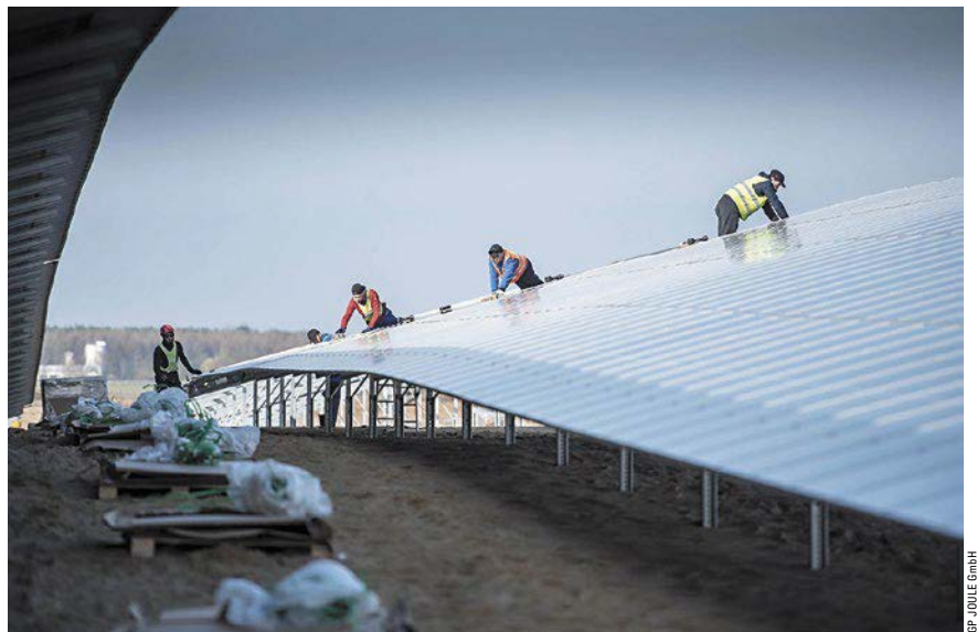
Bau eines Freiflächen-Solarkraftwerks (in Ganzlin, Mecklenburg-Vorpommern): kommunale Teilhabe wie bei der Windkraft?
