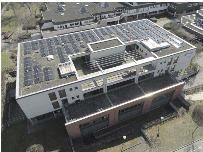
Idealfall: Der Aufwand zum Bau der 100-Kilowatt-Anlage auf der Schule der Körperbehindertenförderung Neckar-Alb (KBF) in Mössingen war hoch, dafür aber lassen sich hier über 90 Prozent Eigenverbrauch realisieren
