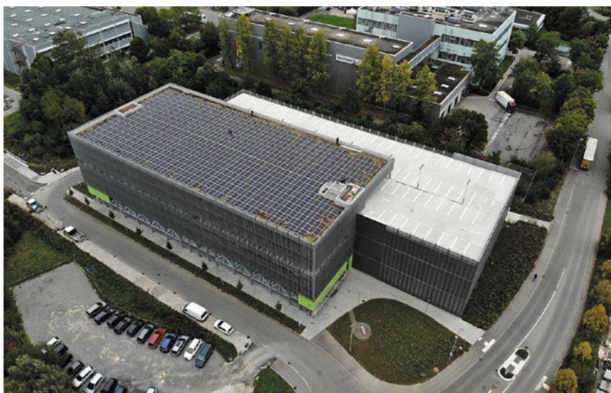
Eigenverbrauch mit Perspektive: Nur zehn Prozent vom Ertrag dieser 316-Kilowatt-Anlage werden direkt in diesem Reutlinger Parkhaus verbraucht. Das könnte sich ändern, wenn dort künftig mehr Elektroautos abgestellt werden
