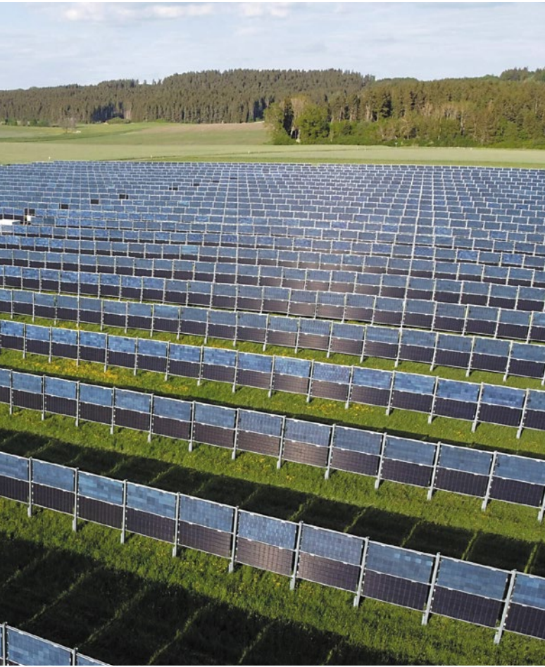
Aufständerung installiert werden. Wie bei dieser Anlage in Aasen, einem Stadtteil von Donaue-
