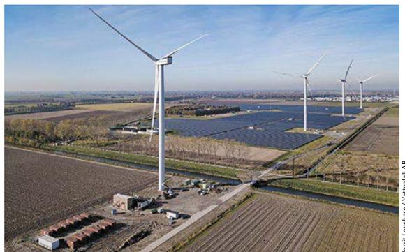
Der Energiepark Haringvliet ist der erste Hybridpark von Vattenfall. Er besteht aus sechs Windturbinen, 115.000 Solarmodulen und 12 Containern mit Batterien.
