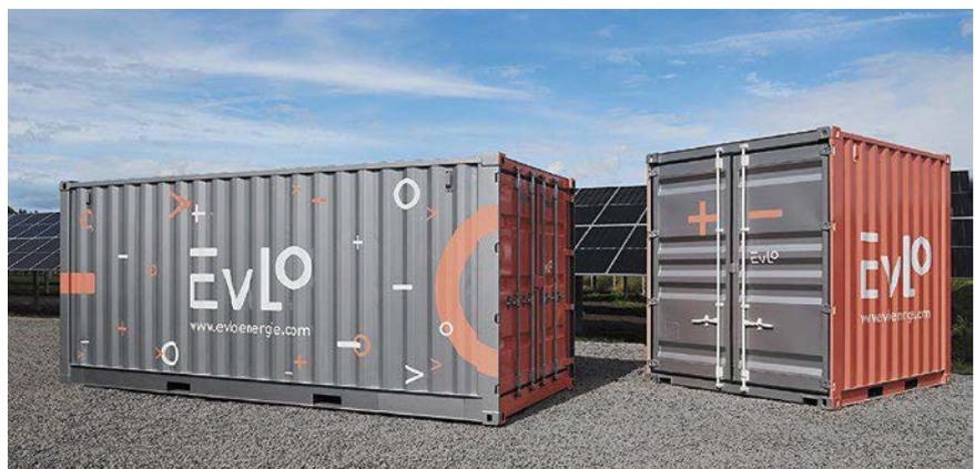
Energiespeichersystem »Evlo« auf Basis von Lithium-Eisen-Phosphat
