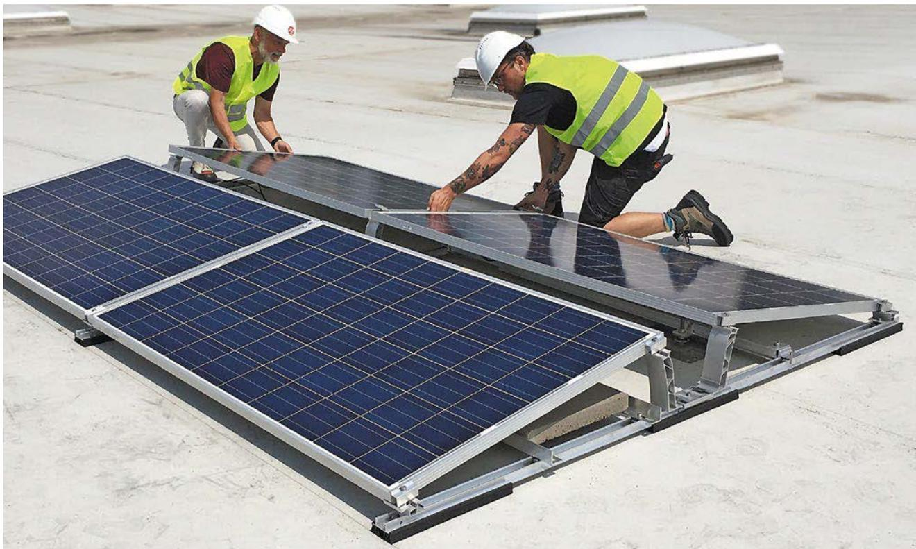
Keine Patentlösung in Sicht: Flachdach-System mit Ballastierung (»Dome 6 von K2 Systems«)
