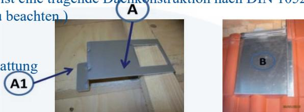
3. Dachpfanne (B) einlegen und mit dem rückseitigen Anschlagwinkel an der Dachlatte anschlagen.
